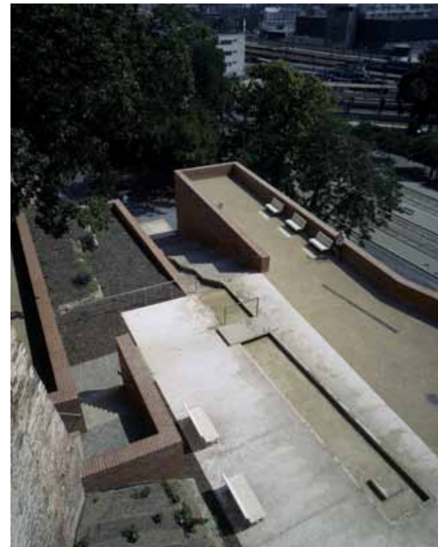
Obr. VI: Denisovy sady, IV.–V. etapa, doplnění opěrných zdí hradebního systému u ulici Bašty, z archivu autora
